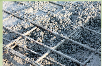
Getti strutturali come fondazioni, plinti, travi ecc.
